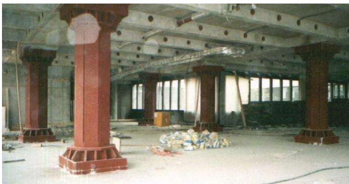
Verstärkung des Bestands
