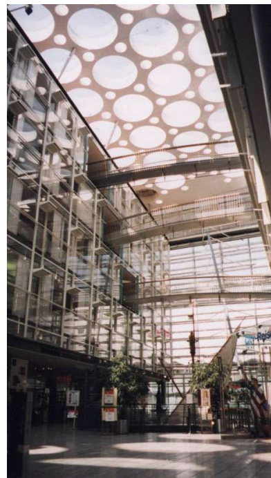
Dachkonstruktion über Innenhof
