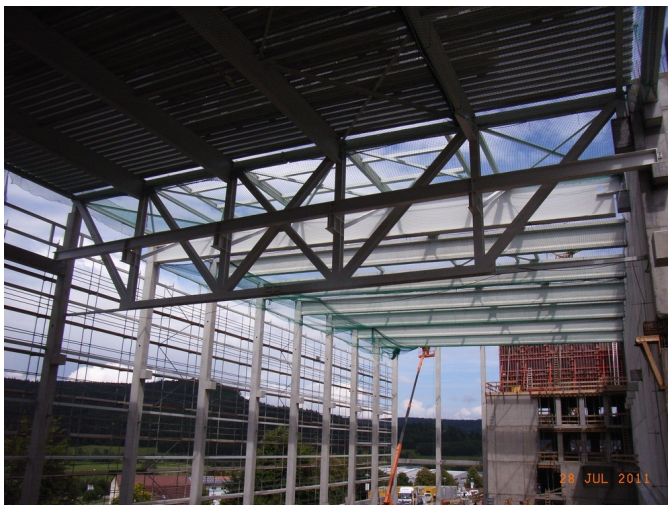
Innenansicht Fachwerkträger im Bauzustand
