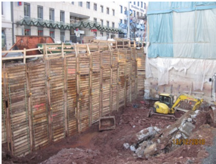
Baugrube und rückverankerte Unterfangung der Nachbarbebauung in der eng bebauten Innenstadt
