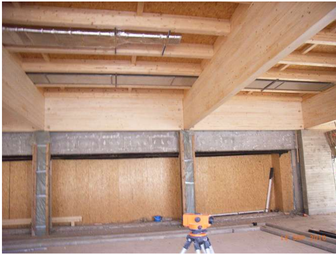
Stahlbetonkonstruktion und BSH-Binder in der Bauphase
