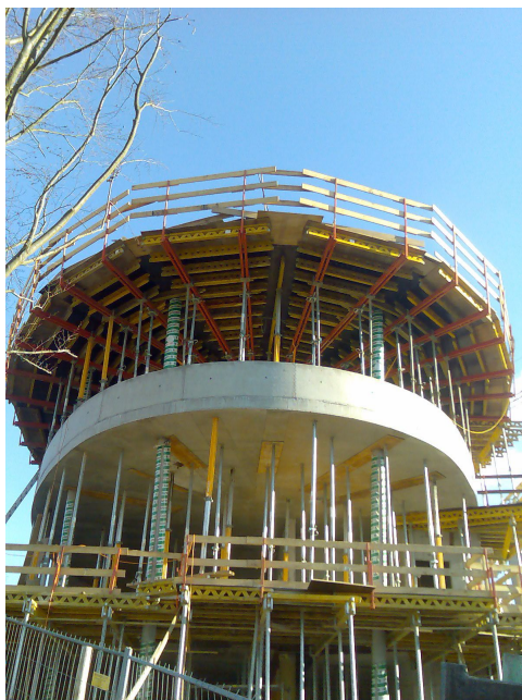
Turm während der Bauphase
