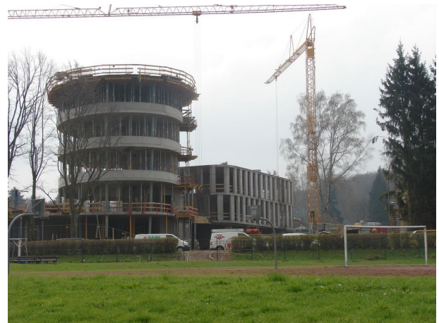
Gebäude-Ensemble während der Bauphase
