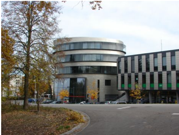
Ansicht Turm und angrenzende Verwaltungsgebäude
