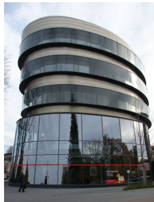
Ansicht fertiger Turm
