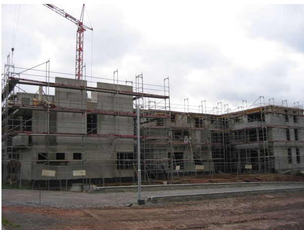
Rückansicht in der Bauphase
