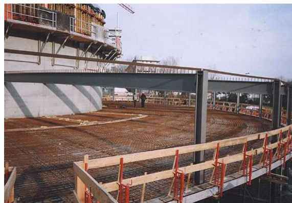
Decke über Erdgeschoss im Bauzustand
