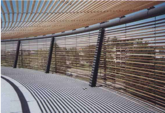
Seil-Holzkonstruktion Fassade und Dach
