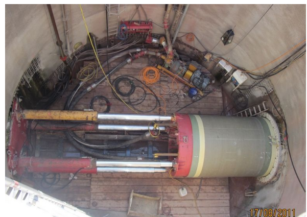
Rohrvortrieb (Anfahrvorgang)
