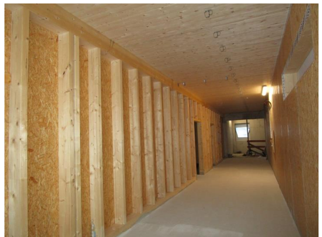
Innenansicht während der Bauphase
