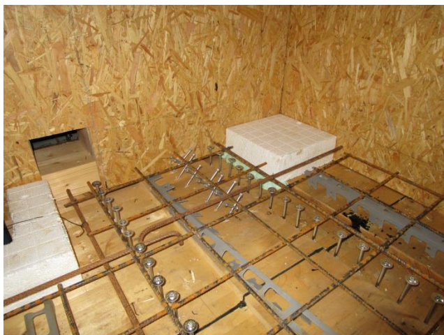
Holz-Beton-Verbunddecke vor dem Betonieren
