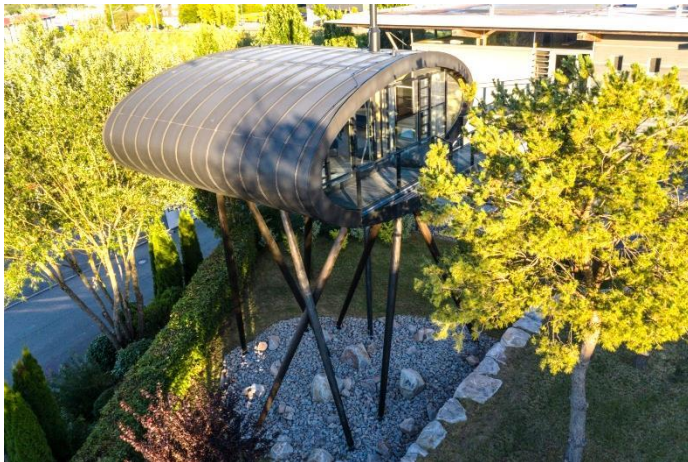
Ansicht fertiges Besprechungshaus (Foto: Andreas Wenning)
