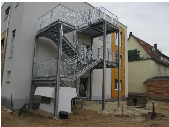
Fluchttreppe als Stahlkonstruktion
