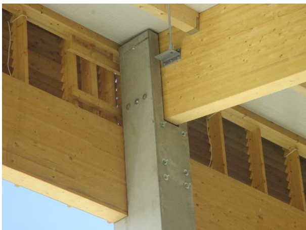
Anschlussdetail Leimholz Binder an Stahlbetonstütze
