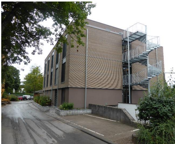
Außenansicht mit Stahltreppe
