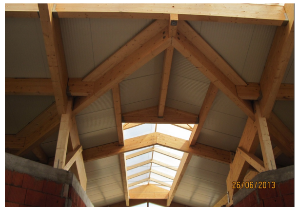
Detail Dachkonstruktion Pferde­stall
