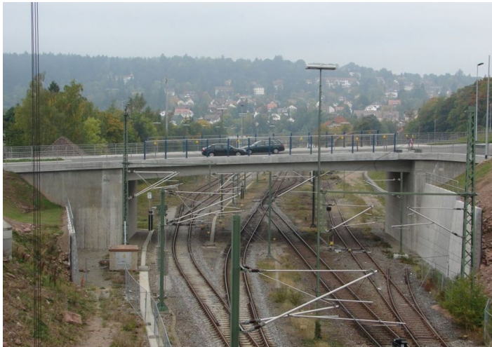
Ansicht fertiges Brückenbauwerk
