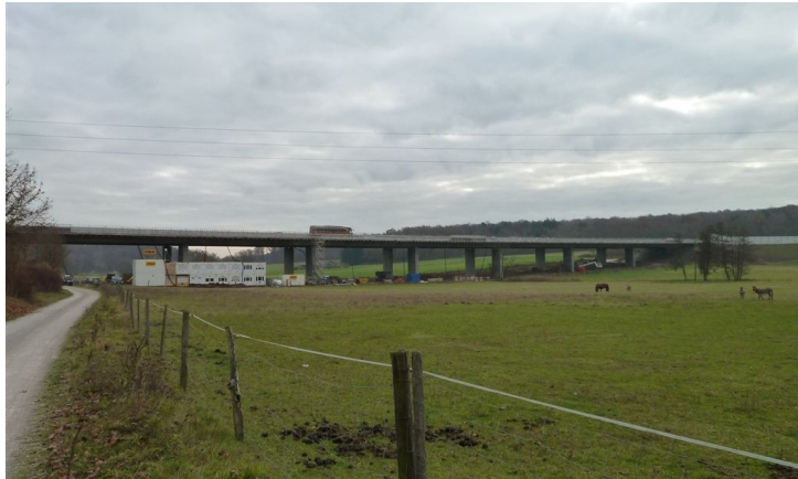
Brückenansicht während der Instandsetzung
