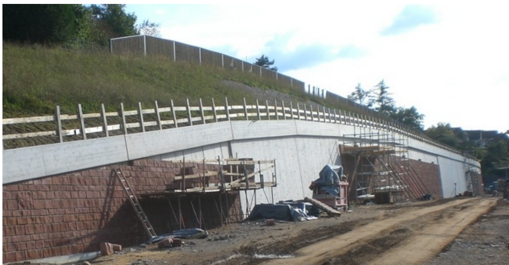
Bauphase: oben Bohrpfähle und Pfahlkopf, unten Verblendmauerwerk
