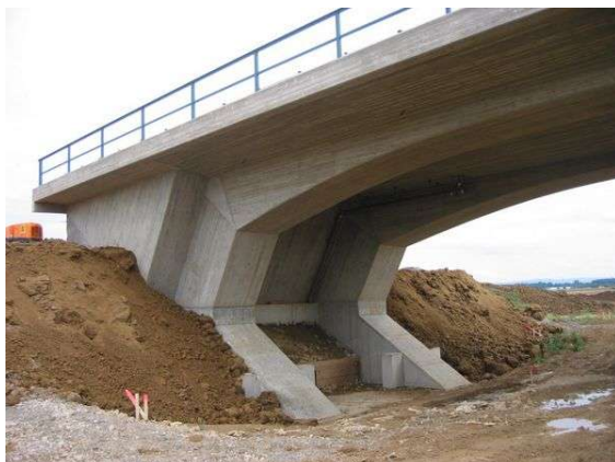
Detail Widerlager und Flügelwand
