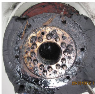
Detail Ankerkopf
