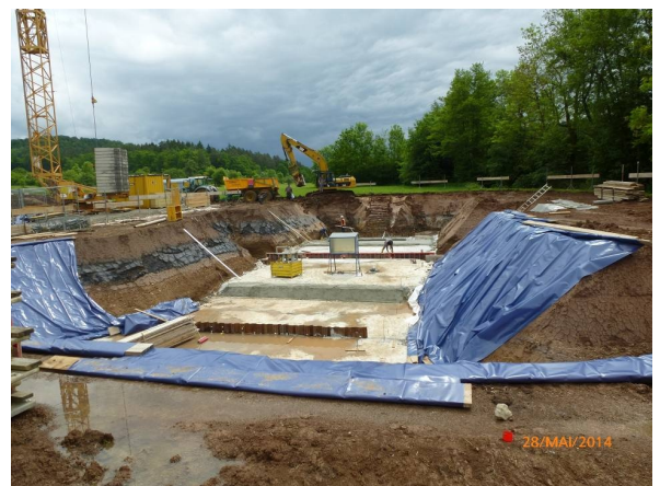
Baugrube mit Sauberkeitsschicht und Spundwänden gegen Unterspülung des Bauwerks
