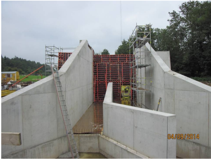
Unterwasseransicht des fast fertigen Auslassbauwerks (beidseitige Dammschüttung fehlt noch)
