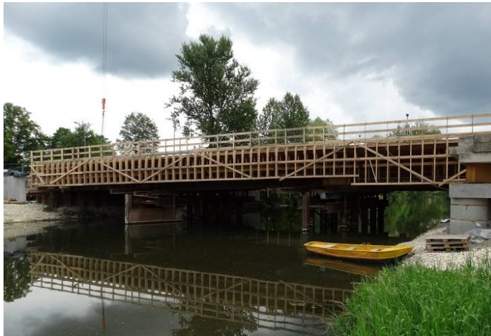
Ansicht Brückenbauwerk mit Traggerüst im Bau
