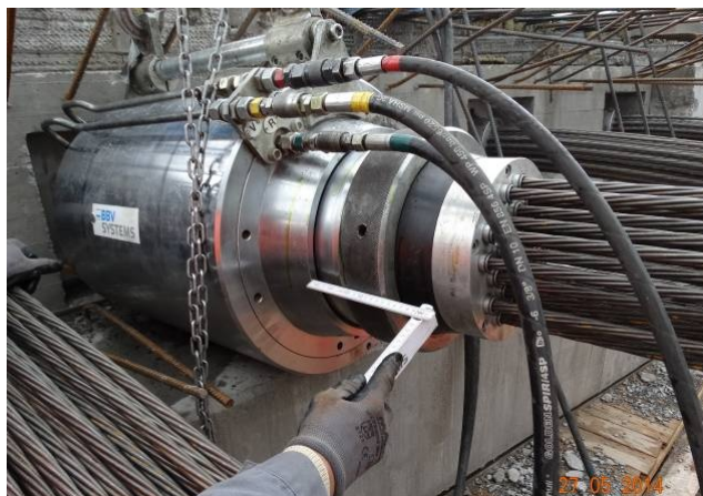
Presse während des Vorspannens der Spannlitzen
