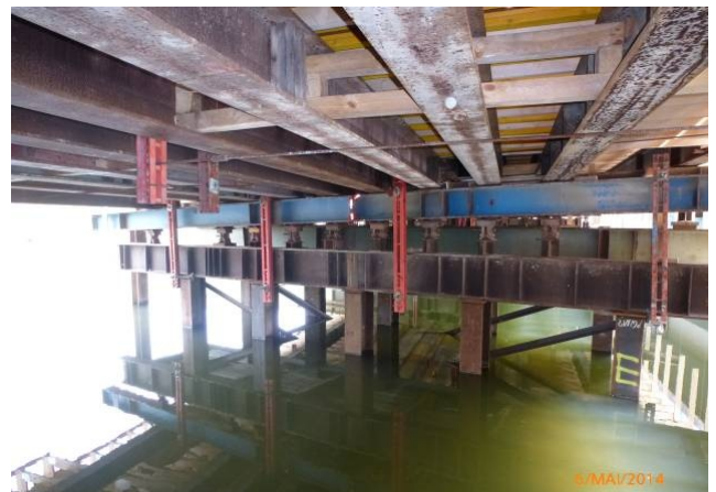
Untersicht Traggerüst mit Hilfsjochen in der Donau
